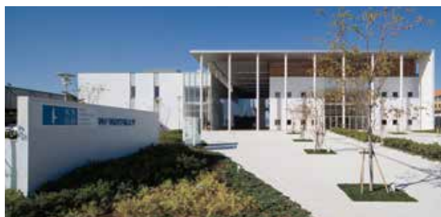
6 夙川学院 所在地 兵庫県神戸市中央区港島1丁目3-11 敷地面積 7,623.60坪
